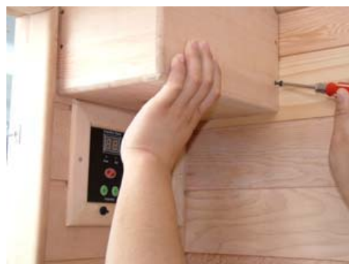
FIG-22.1 bevestig de afscherming met schroeven
