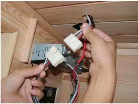
FIG-18 verbind de radiocontacten
