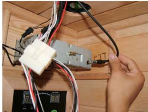
FIG-21 verbind de antenne
