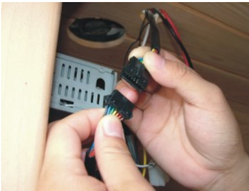
FIG-20 verbind de stekker van het controlepaneel
