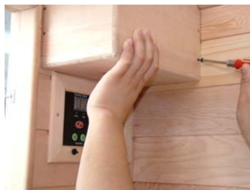
FIG-22.1 bevestig de afscherming met schroeven
